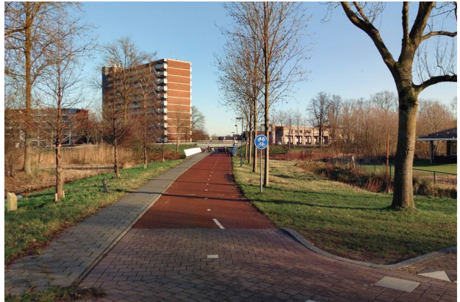
AANZICHT FIETSPAD GROENEVELDSELAAN VANAF DE GREBBEWEG, 2018 ©2021 CYCLOMEDIA
