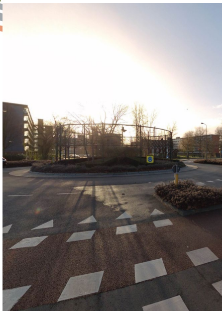
AANZICHT FIETSPAD GROENEVELDSELAAN VANAF DE GREBBEWEG, 2018 ©2021 CYCLOMEDIA
